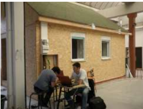
La maison en construction
